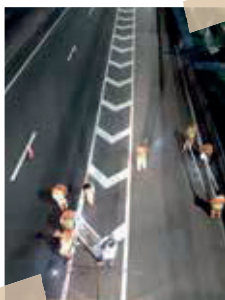
PINTURA DE FAIXAS
