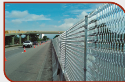
A CCR RioSP está com obras de implantação de telas antiofuscantes ao longo da rodovia Rio-Santos (BR-101). Foram implantados quase 7 mil metros de novas telas na rodovia entre Itaguaí e a cidade do Rio de Janeiro. O dispositivo proporciona mais segurança e conforto aos motoristas da rodovia, pois minimiza o ofuscamento do campo de visão causado pela luz dos faróis dos veículos que trafegam no sentido oposto. Além disso, direciona a travessia de pedestre para as passarelas.
