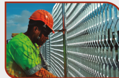
A CCR RioSP está com obras de implantação de telas antiofuscantes ao longo da rodovia Rio-Santos (BR-101). Foram implantados quase 7 mil metros de novas telas na rodovia entre Itaguaí e a cidade do Rio de Janeiro. O dispositivo proporciona mais segurança e conforto aos motoristas da rodovia, pois minimiza o ofuscamento do campo de visão causado pela luz dos faróis dos veículos que trafegam no sentido oposto. Além disso, direciona a travessia de pedestre para as passarelas.
