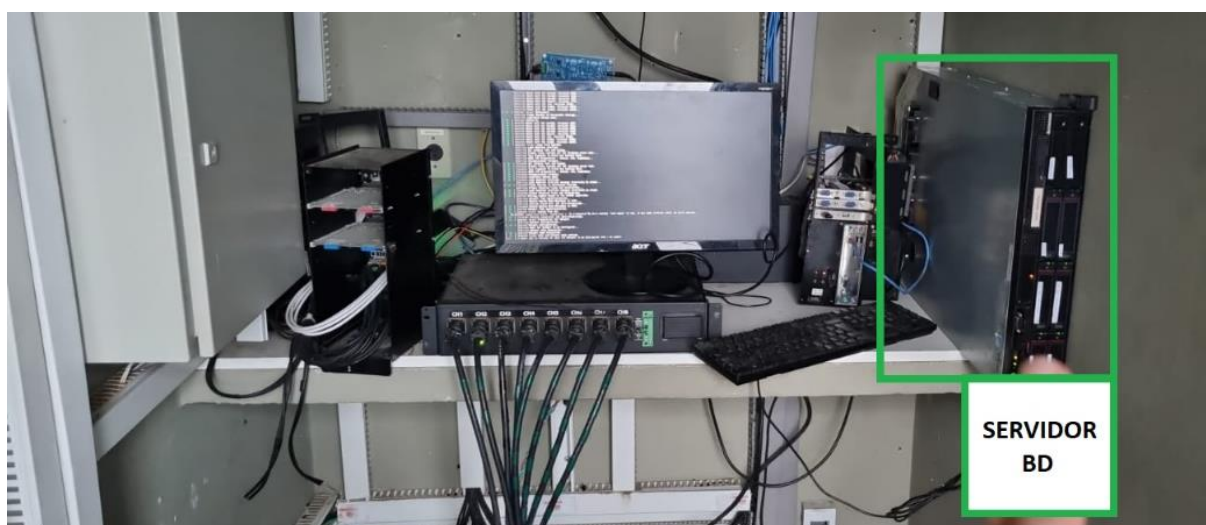
Figura 23 – Servidor para banco de dados instalado no sítio de pesquisas (abrigo da PCCA)
