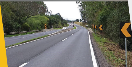
REVITALIZAÇÃO DA SINALIZAÇÃO HORIZONTAL
