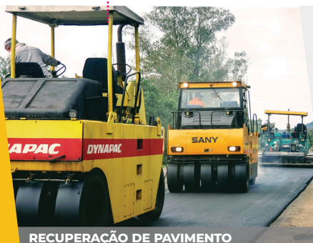
RECUPERAÇÃO DE PAVIMENTO
