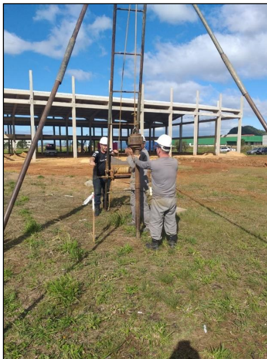
Foto 2. Execução da sondagem SPT na área de estudo durante a etapa de batida.
