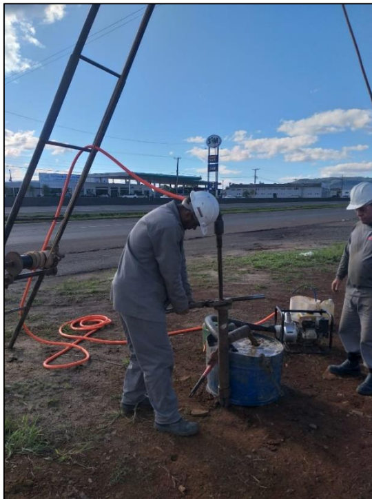
Foto 1. Execução de sondagem SPT com sistema manual.
