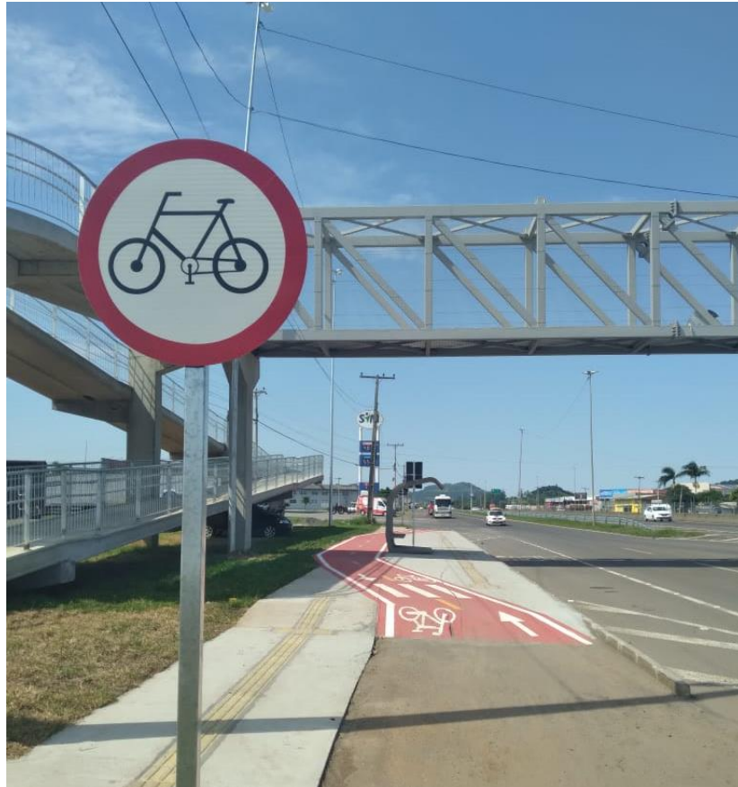
Figura 11 – Sinalização e ciclovia – Passarela.
