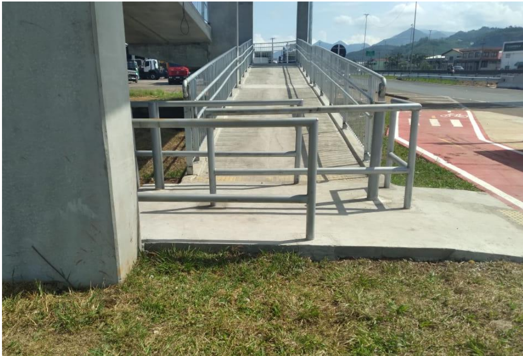
Figura 05 – Trava moto e rampa – Passarela.
