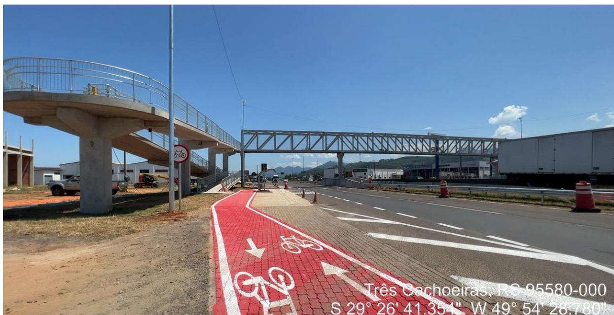
Figura 10 – Sinalização e ciclovia – Passarela.
