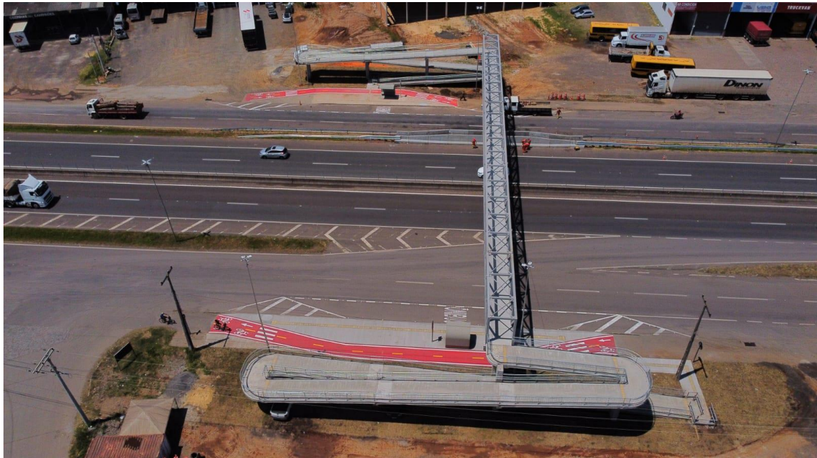
Figura 03 – Vista aérea – Passarela.
