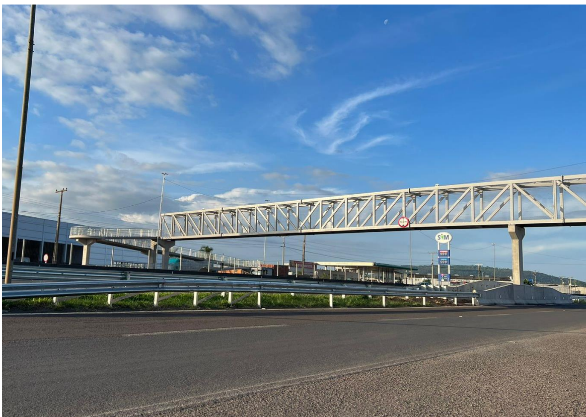
Figura 04 – Vista geral – Passarela.
