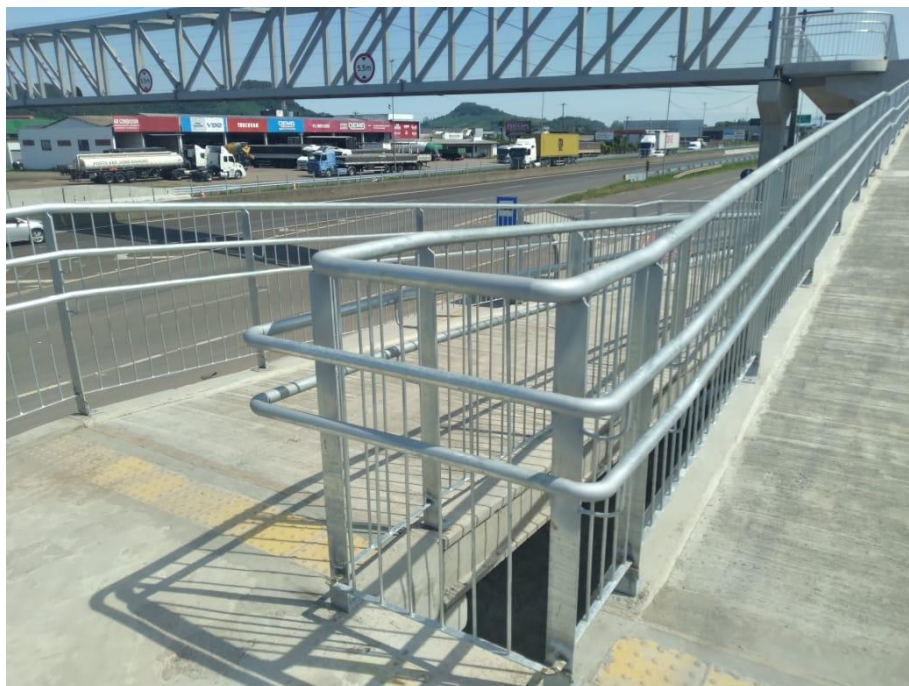
Figura 12 – Piso tátil/rampa – Passarela.
