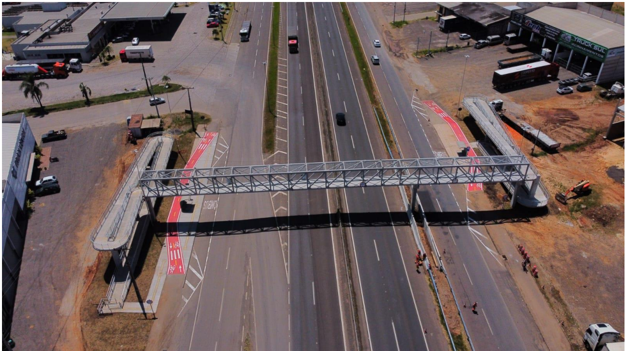
Figura 02 – Vista aérea – Passarela.
