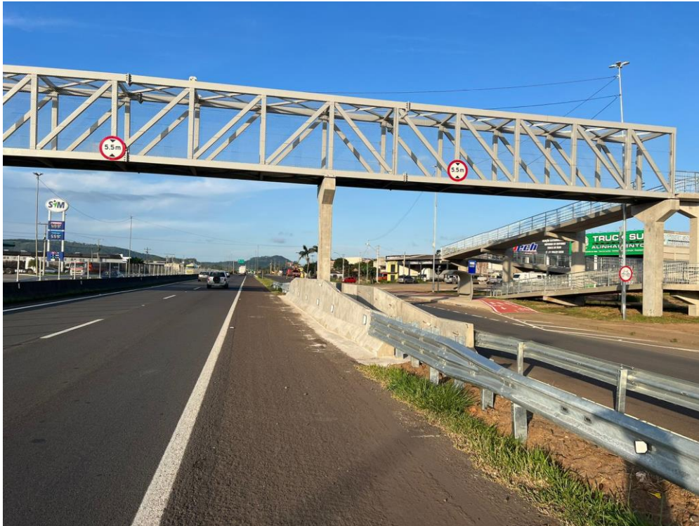
Figura 13 – Travessia e EPS – Passarela.
