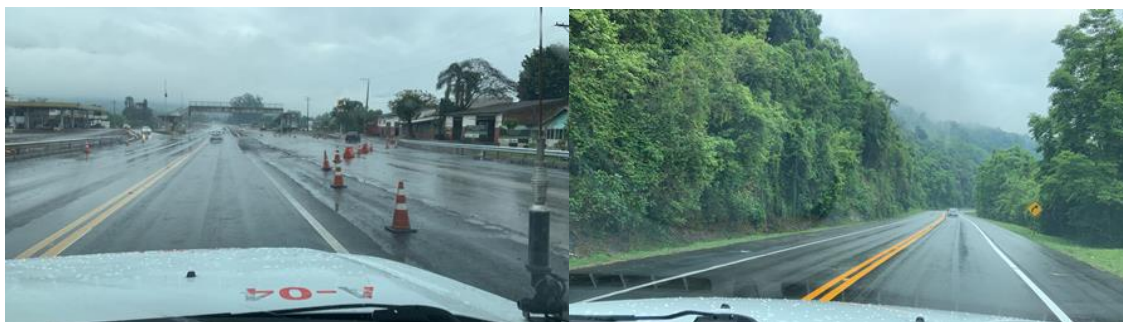
Figura 5 - Trecho com obras de duplicação, e região com árvores altas na beira da rodovia.
