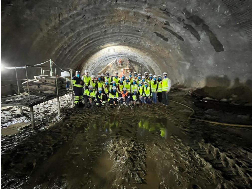
Figura 42 – Equipe PETER ViaSul no túnel da obra do Contorno de Florianópolis
