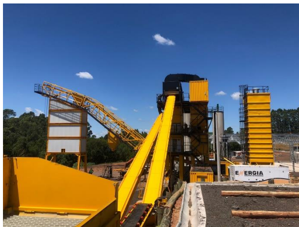
Figura 55 - Fotos da obra de implantação da nova usina da CCR ViaSul registradas pela PETER Fernanda Wilson
