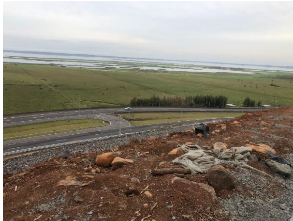
Figura 56 - Fotos de acompanhamento de obra registradas pela PETER Fernanda Wilson
