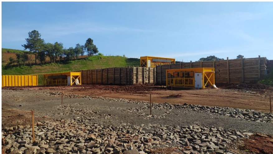
Figura 27 - Fotos da obra de implantação da nova usina da CCR ViaSul registradas pela PETER CCR/ViaSul Joana Garcia
