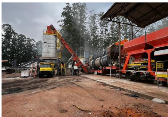
Figura 103 - Fotos da usina de asfalto Eldorado mineração registradas pela PETER Sophia Hoppe
