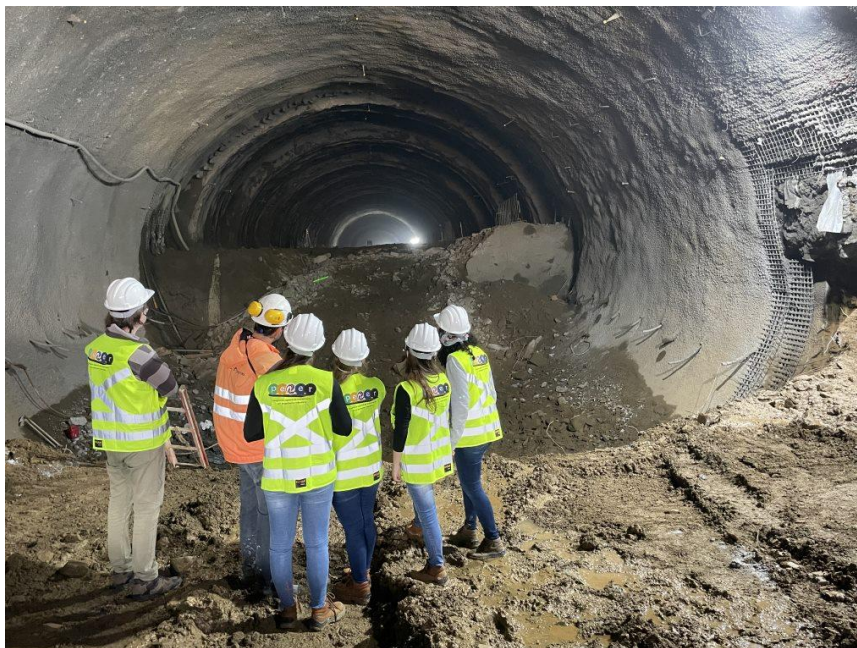
Figura 41 - Registros realizados na visita técnica à obra do Contorno de Florianópolis
