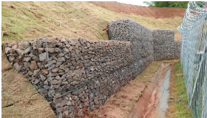
Figura 28 - Fotos da obra de implantação da nova usina da CCR ViaSul registradas pela PETER CCR/ViaSul Joana Garcia
