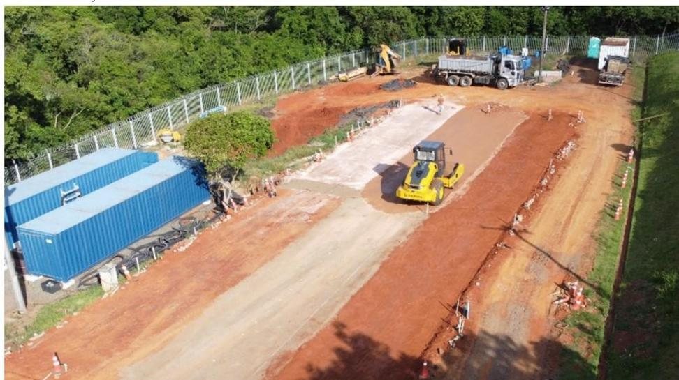
*Compactação das bases (BGS) e instalação da rede de drenagem profunda*
